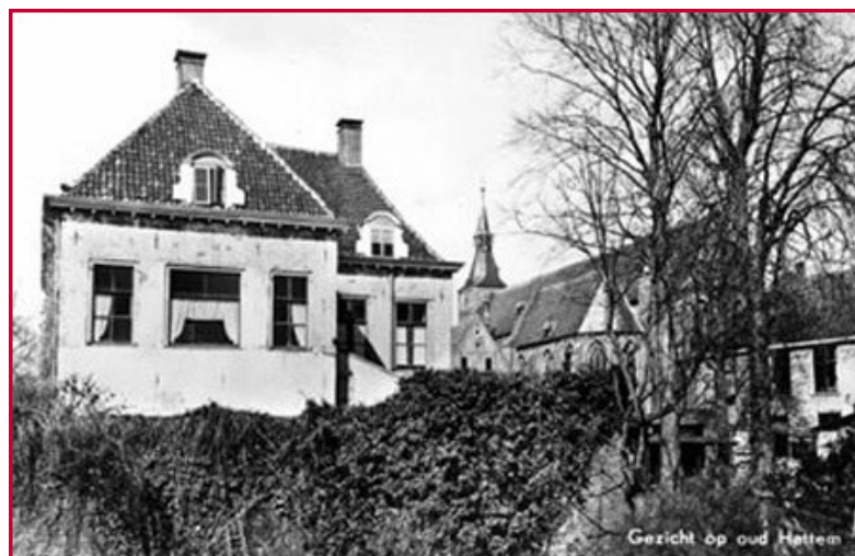
Voormalig woonhuis van de generaal te Hattem
